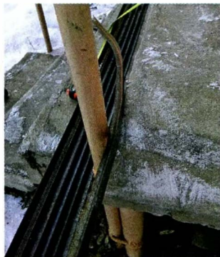
Сгибание стоек с использованием подручных средств.
