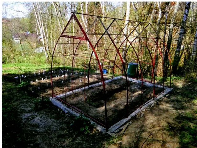
Каркас в основном собран. Средней форточки и двери ещё нет.
