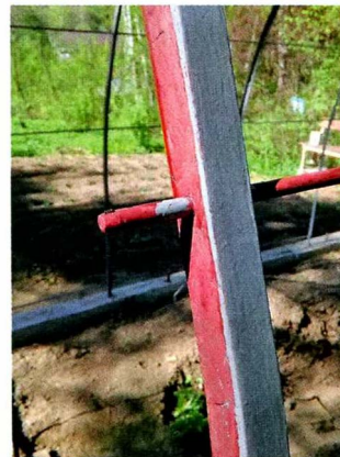
Выход прутка на торце. Контактная поверхность под поликарбонат покрашена серой эмалью по грунту.
