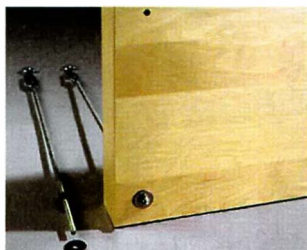
Полка будет висеть на резьбовых шпильках М8. Фиксируем гайками шпильку с обеих сторон доски, не забываем подложить шайбу.
