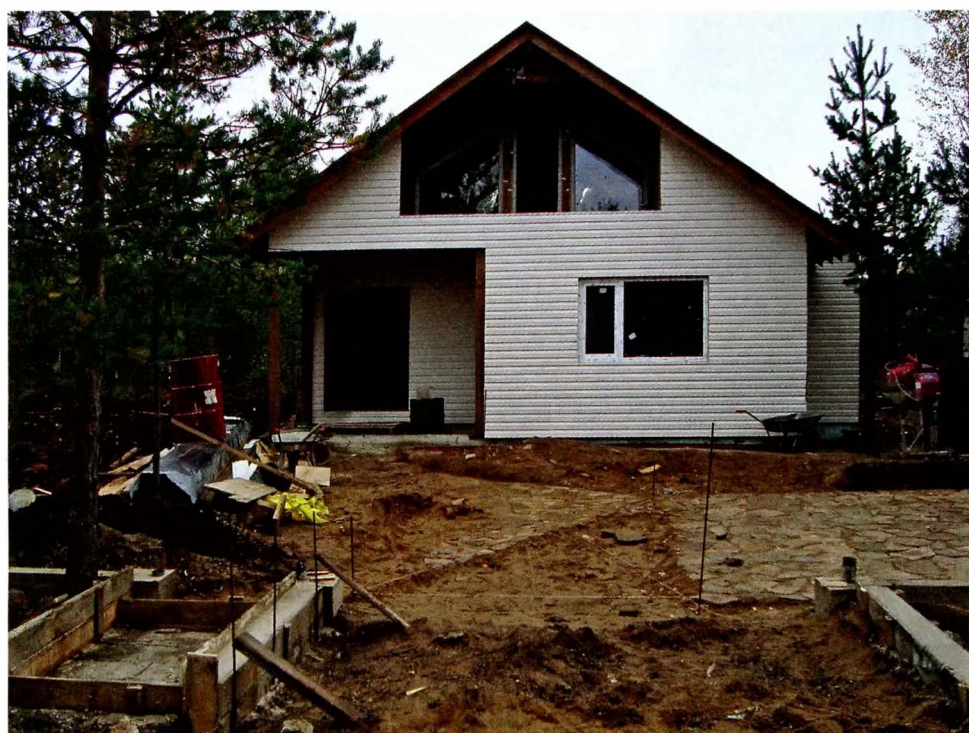
Отливаем железобетонные бордюры на заезде на участок.
