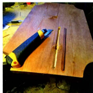
С обратной стороны выбрана глубокая канавка под проводку. Сверху провод будет закрыт тонкой рейкой.
