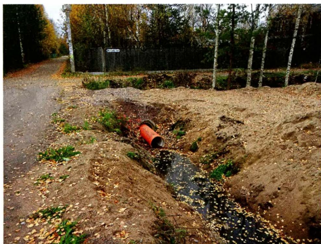
Пластиковая труба на заезде на участок.
