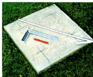
Отверстия надо точно разметить, перед тем как сверлить. Отверстия должны совпадать на обеих плитках.
