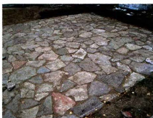
Укладка каменных плит на поверхности парковки.
