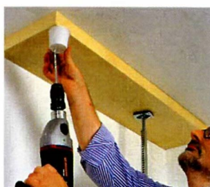
Прикладываем полку к потолку и сверлим в нём отверстия (через отверстия в полке). Для сбора мусора используем пластиковый стаканчик.
