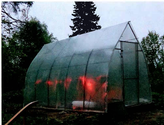
Теплица, вид сбоку. Сверху ещё не хватает конька.
