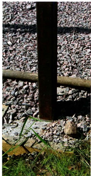
Опорные стойки навеса, замоноличенные в свайный фундамент.
