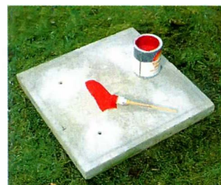
Перед сборкой плиты с внешней стороны можно покрасить огнеупорной краской.
