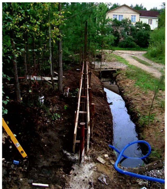
Железобетонная труба на заезде на участок.
