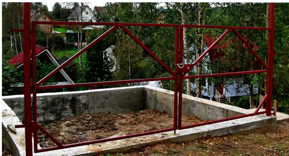
Устройство парковочной площадки на склоне.
