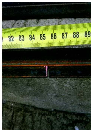
Надрезы для придания нужной формы ската.
