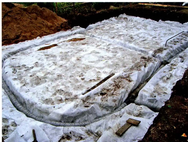
Котлован под парковку, выложенный геотекстилем, с уложенными дренажными трубами 110 мм в фильтрах.
